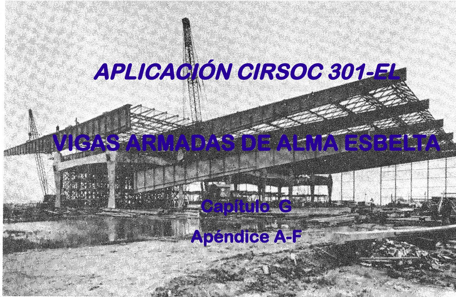
**Figura 7.3** Trabes armadas que soportan el techo del hangar de United Airlines en San Francisco; consisten en un claro central con voladizos de 142 pies. (Cortesía del American Institute of Steel Construction.)
